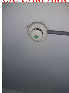
U/C CARPARK FAN D81
