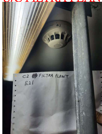
U/C FILTRA PLANT E21
