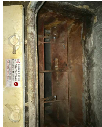
項目26 位置：9/F C室右冷氣機房（地台）
