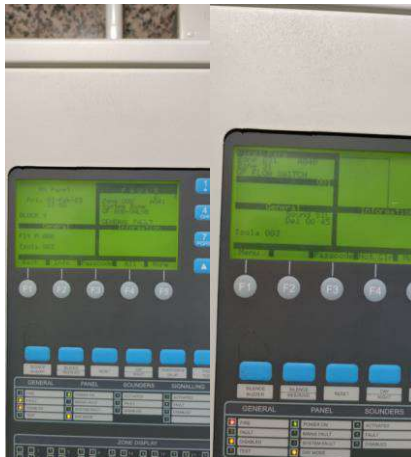
R/F 發電機房(A93),S93 內閘掣(A40)和流水掣(A41)
