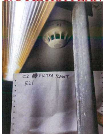
U/C FILTRA PLANT E21
