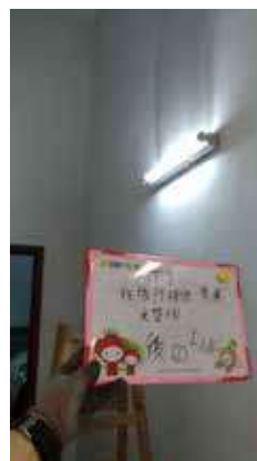
位置：L2/F 後門防煙門 更換緊急照明燈 #2
