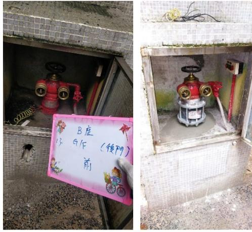
14. A) 提供人手及工具挖掘上水消防泵房前地掣至泵房地喉石屎面 (約 0.5 米 X2 闊米長 X1 米深)
