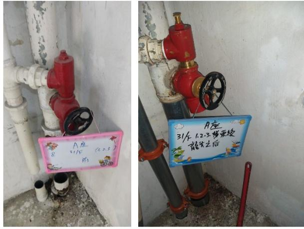
9. 更換龍頭白膠圈 (原因:老化失效) 位置:1/F-35/F (共 70 個,扣除第 8 項更換龍頭 3 個)
