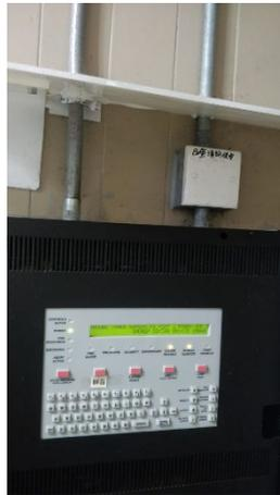
6. 更換消防 2 號泵訊號模塊 (原因: 故障)
