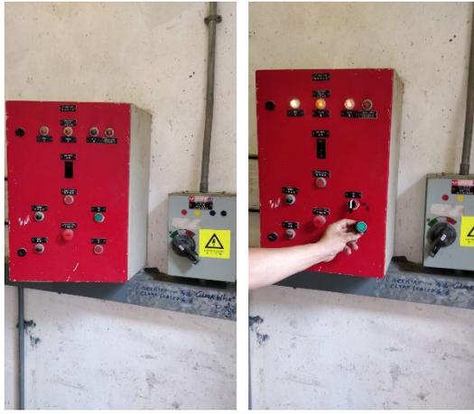
5. 查修管理處的消防數碼 panel 底板 (原因:顯示有故障訊號)
