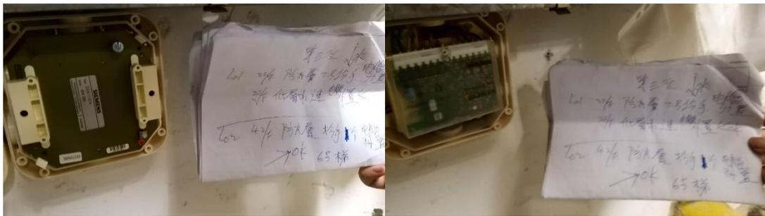
(1d) 更換自動報警系統熱度頭(型號:DT1152A) 數量:6 個
