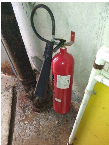
標書 35 更換 5KG CO2 滅火筒 (3 座地下電訊房)
