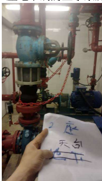
標書 13 維修消防2號中途泵 (1座地下消防上水泵房)
