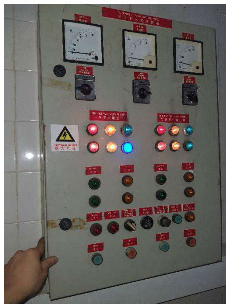
標書 32 更換消防上水泵控制箱指示燈 (3 座)
