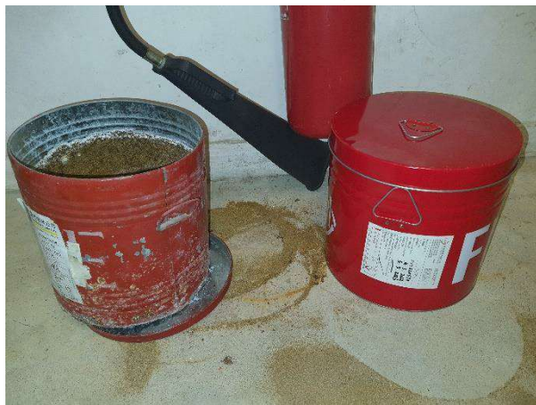
標書 24 更換防火沙筒 (2座天台發電機房)
