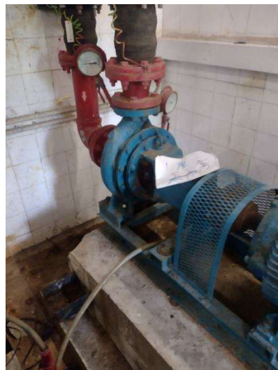
標書 26 維修消防 2 號泵 (3座地下消防上水泵房)
