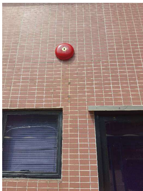
標書 21 更換 8 吋 24V 消防警鐘 及跟查連維修線路 (2 座地下大門口側)
