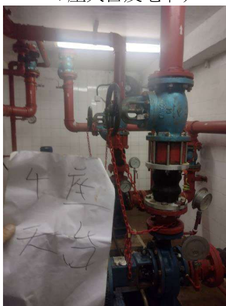
標書 38 安裝消防泵閘掣掛鎖連標籤 (4 座天台及地下)
