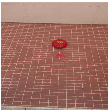
標書 34 更換 8 吋 24V 消防警鐘及跟 查連維修線路 (3 座地下大門口側)
