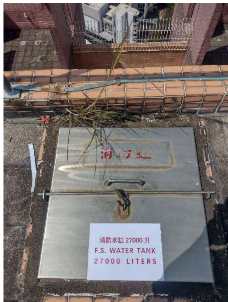
標書 27 安裝消防水缸容量牌 (3 座天台)
