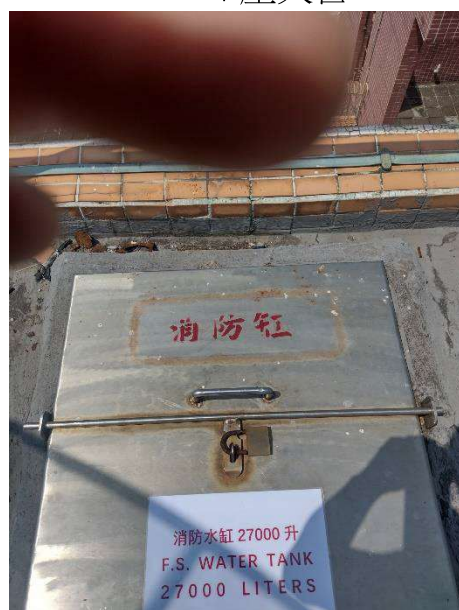
標書 37 安裝消防水缸容量牌 (4 座天台)
